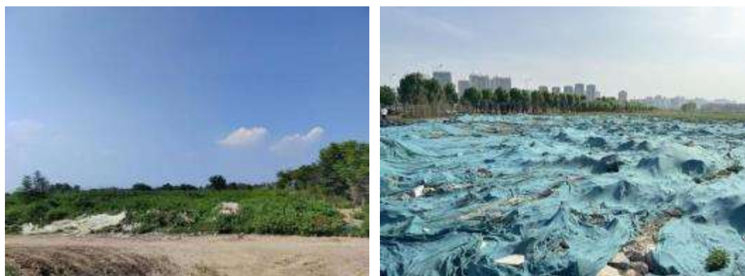
附图 1- 2 宏力大道东孟姜女河雨水泵站汇水区域建设工程选址现状图
