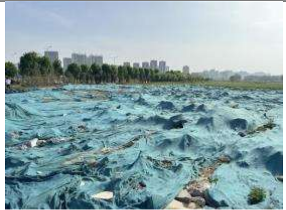
宏力大道雨水泵站现状
