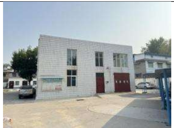
向阳雨水泵站现状
