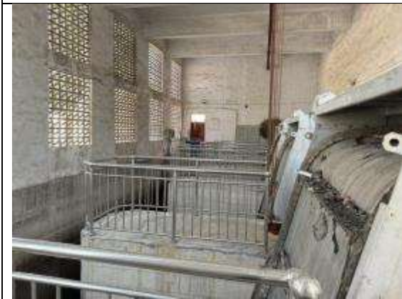
向阳雨水泵站现状
