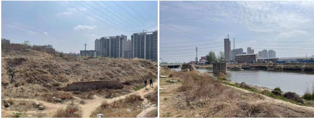
图 6-1 河道沿线设施及河岸现状（部分）
