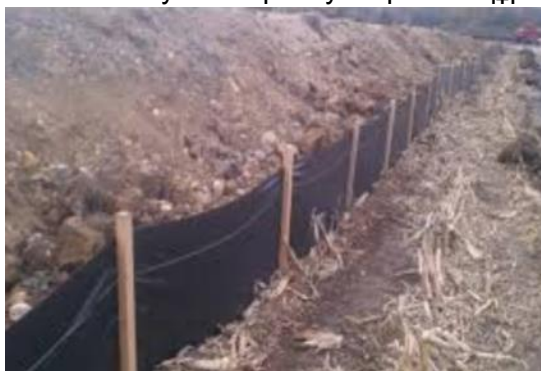
6 сурет – Топырақ эрозиясын және нөсер суымен артық шөгуге жол бермеу үшін топырақ үйінділерінің айналасындағы лай қоршаулары
