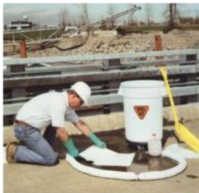
7 сурет - Құрылыс алаңында төтенше жағдайларда отынның /химиялық заттардың төгілуінің алдын-алуға және тазалауға арналған жинақтар болады
