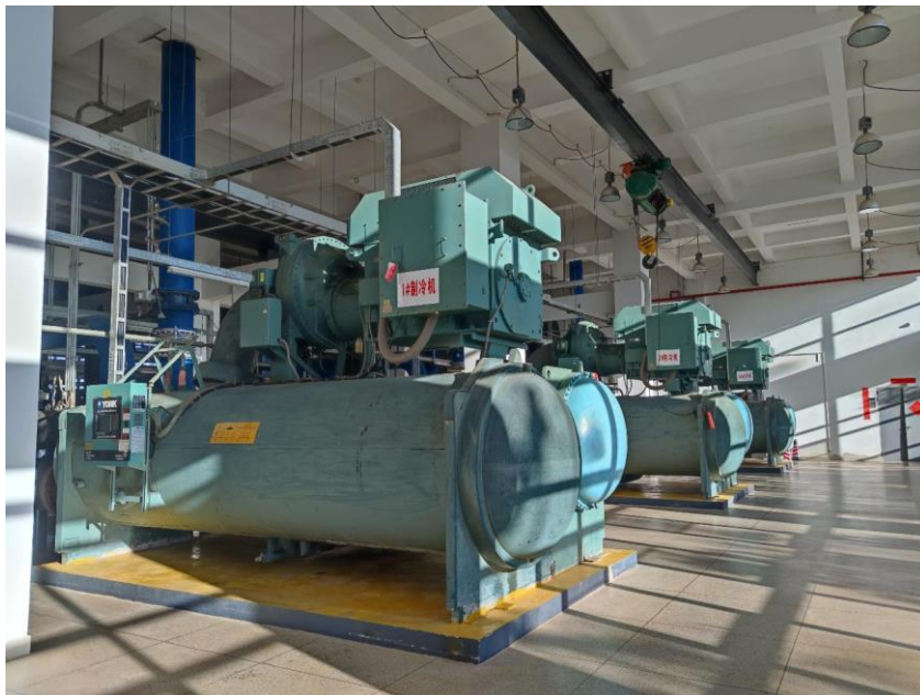
图 12 动力能源中心的冷水机组
