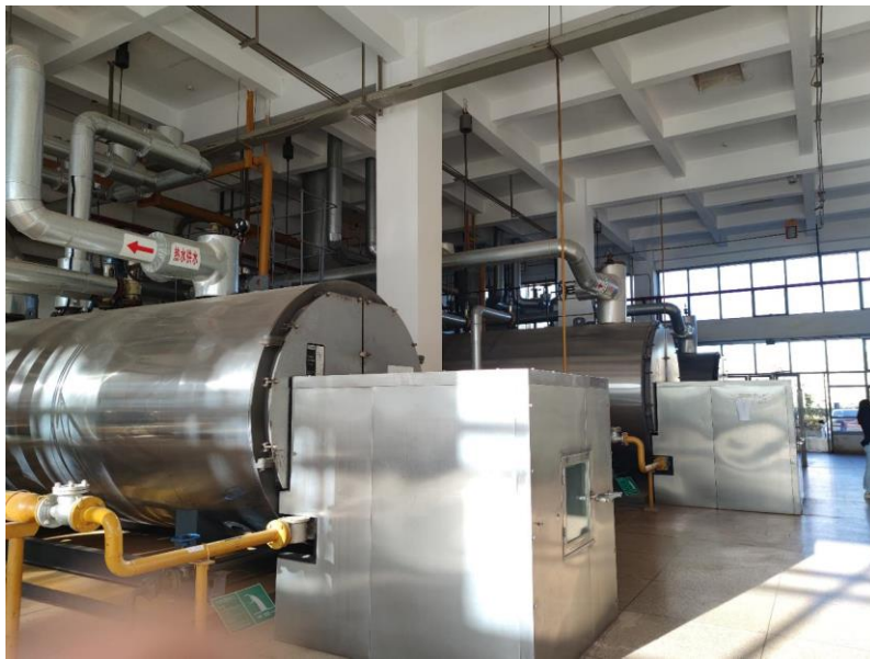
图 10 燃气锅炉
