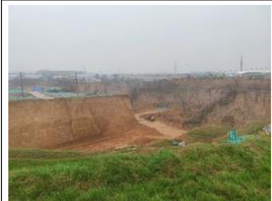
郭家咀水库建设现场图
