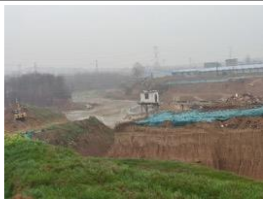
郭家咀水库建设现场图
