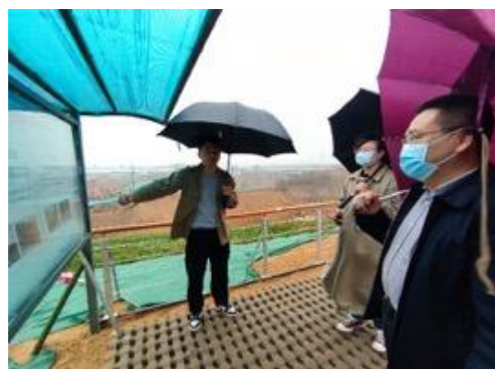
实地勘察郭家咀水库建设现场
