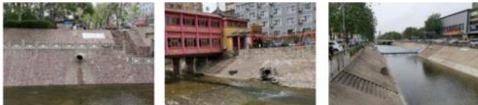
图 4-3 金水河沿线部分混流口及河道内污水管线
