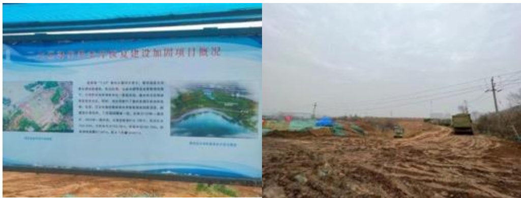
图 3-21 郭家咀水库恢复建设加固项目施工现场（2022 年 3 月）
