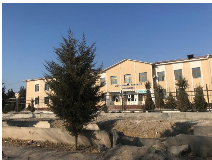
Здание Районного медицинского объединения/больницы в Алатском районе, где очищение сан.узлов осуществляется один раз в неделю.
