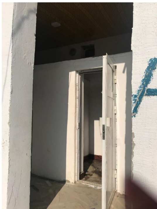
Общий сан.узел для женщин на 100-200 пользователей в новостройке многоэтажного дома.
